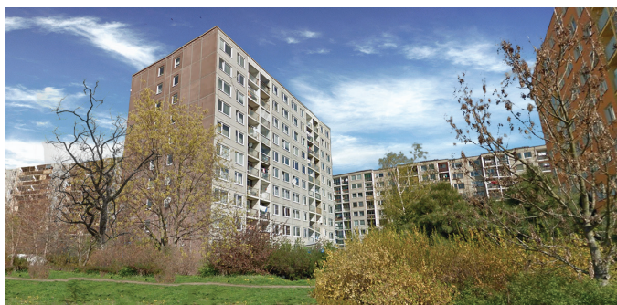
Stávající stav panelového domu v Praze 9
